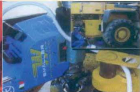
Retificação e soldadura vertical da articulação central de uma retroescavadora sem necessidade de desmontar qualquer tubo hidráulico, ou separação do corpo.
